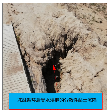
图4 分散性黏土冻融循环和浸泡后大变形破坏状态
